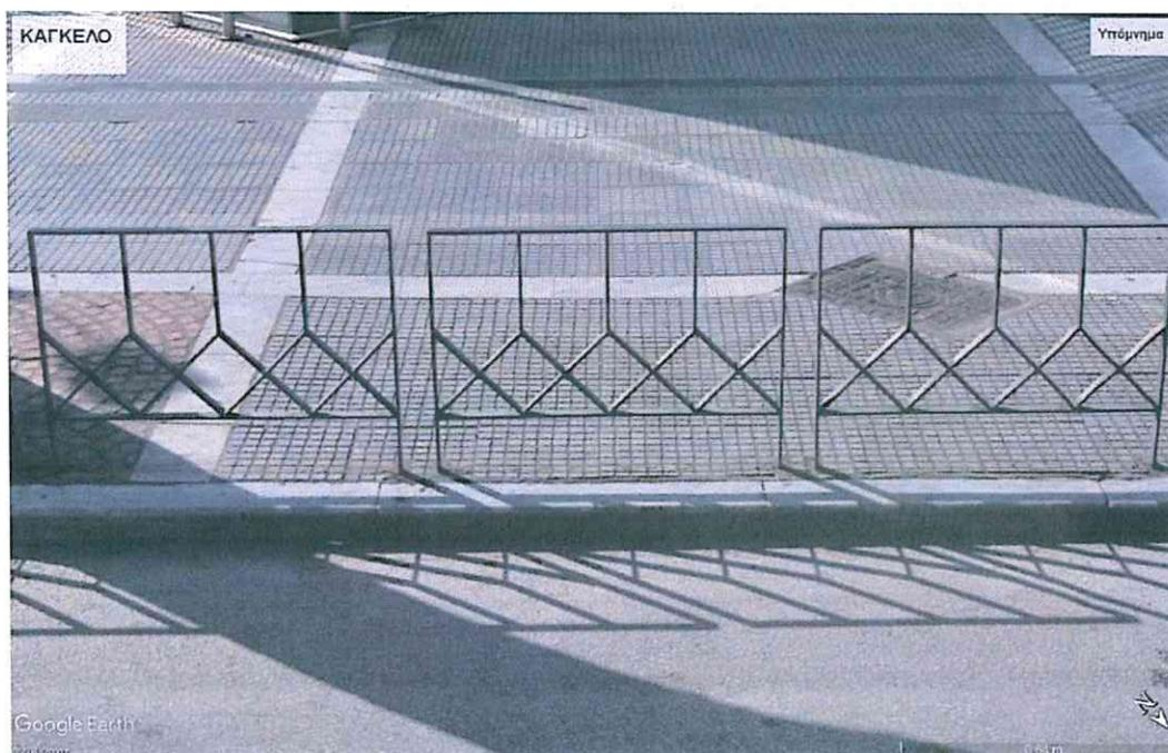
Τα κιγκλιδώματα θα κατασκευαστούν σύμφωνα με το ανωτέρω σχέδιο, από λάμα 40/8 με συνολική διάσταση (ύψος/μήκος) 80/110 cm. Το συνολικό ύψος των εκατέρωθεν κατακόρυφων λαμών/ορθοστατών θα είναι 30cm μεγαλύτερο και θα πακτωθεί σε πλάκα σκυροδέματος. Τα κιγκλιδώματα θα τοποθετηθούν με απόσταση 10cm μεταξύ τους.
